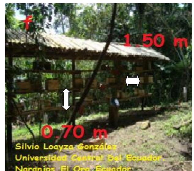
Fig.16. Construcción del Meliponario. **a.** Selección del sitio. **b** y **c.** Instalación y nivelación de las bases o pilares. **d** y **e.** Instalación del techo (Sombra de caña guadua). **f.** Distancia entre colmenas horizontal 1.50 m y vertical 0.70 m.
